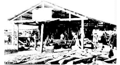
Antigua maderera, semejante a la que había junto a la estación
